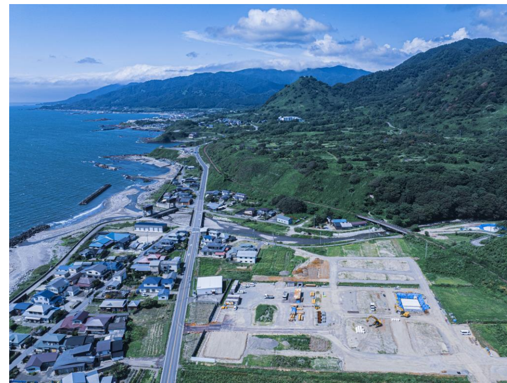
泊川中間養殖場建設地（2024年8月撮影）
