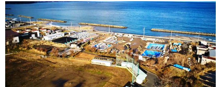
増設工事中の循環式中間養殖場 (青森県今別町)
