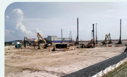
建設現場（2025年6月時点）
