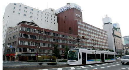
豊橋駅前大通二丁目再開発地区（現況）
