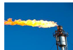
石油・天然ガス
