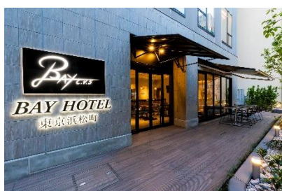
外観（地上10階建て）
