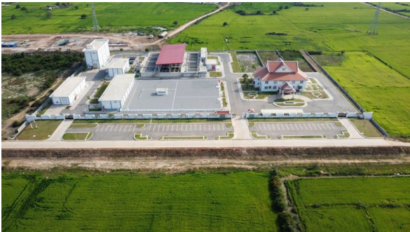
参考：Chreav浄水場 (シェムリアップ上水道拡張事業)
