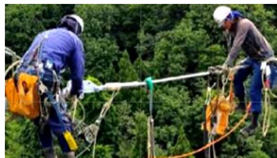
送電線架線工事の様子
