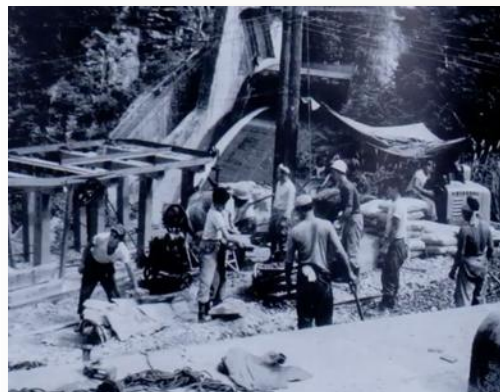
1963年 黒部ダム 電気工事完工
