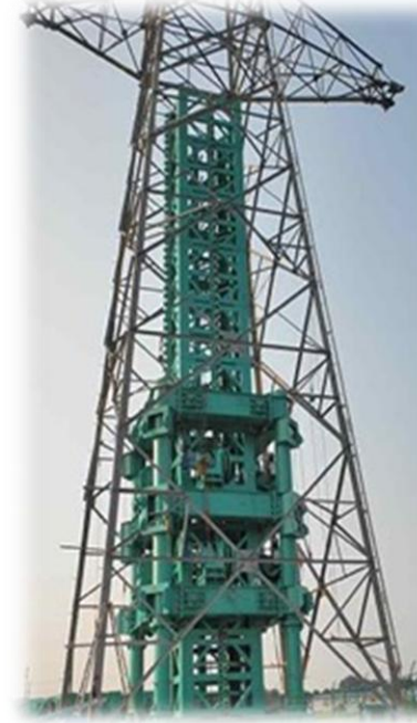
鉄塔嵩上げ装置 「エナーク160」 平成28年 特許取得
