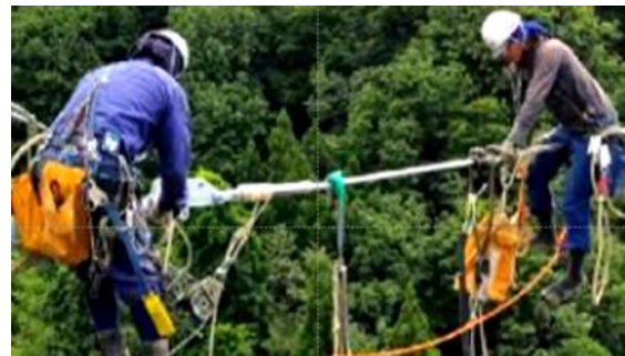
送電線架線工事の様子
