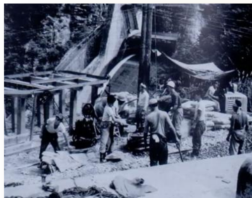
1963年 黒部ダム 電気工事完工
