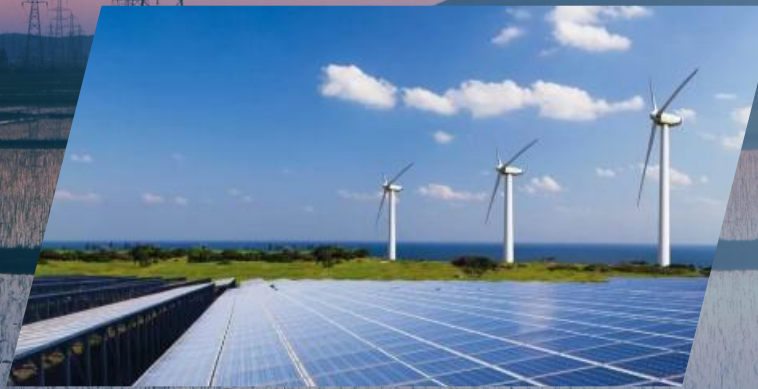
設備事業 (再生可能エネルギー発電所事業)
