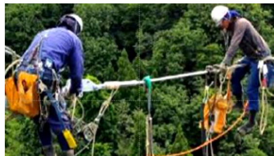
送電線架線工事の様子
