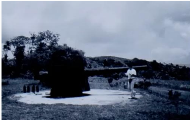
1944年 パラオ諸島で無線塔建設
