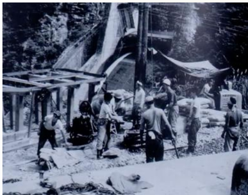
1963年 黒部ダム 電気工事完工
