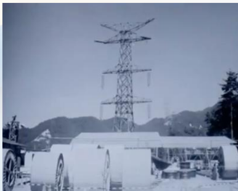
1988年 国内初100万ボルト送電工事受注
