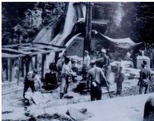
1963年 黒部ダム 電気工事完工
