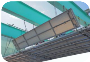
パネル式吊り棚足場 「スパイダーパネル」
