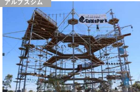
アルプスジム
