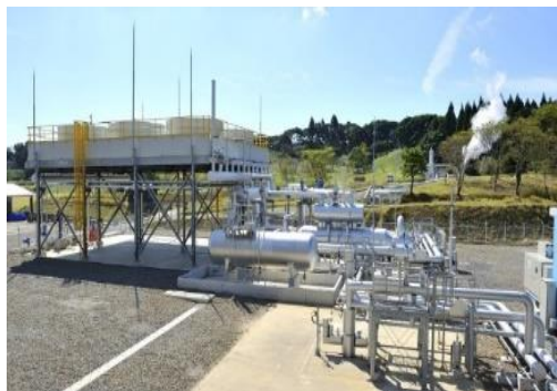
【メディポリス指宿地熱発電所】
