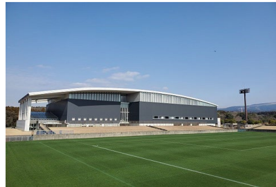
● 大津町総合体育館
