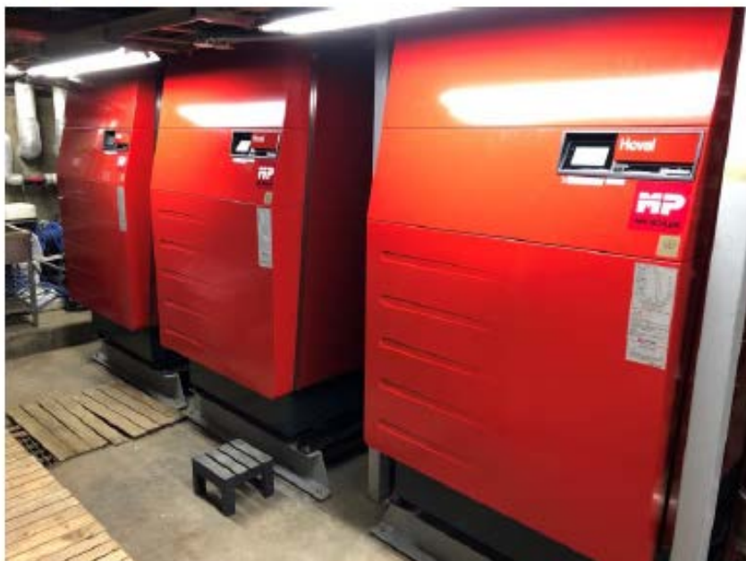
ボイラー入替
