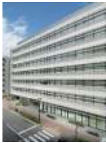
中央区 日本橋馬喰町
