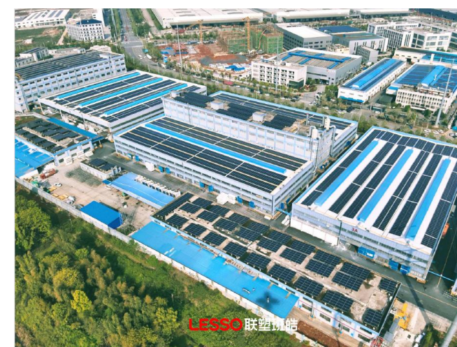
太陽光パネル設置事例
