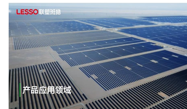
LESSO 太陽光パネル設置状況
