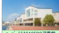
ハーバーテラスSASEBO迎賓館
