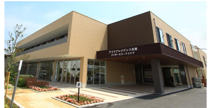
▲ 施設外観写真
