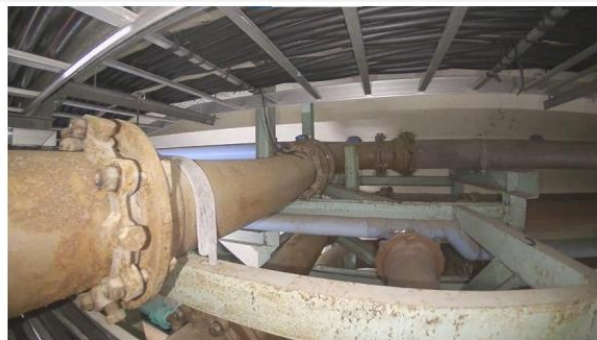
地下管廊内撮影写真
