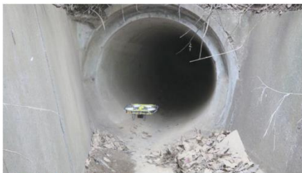
直径約1mの管渠に向かって進入するIDIS。
