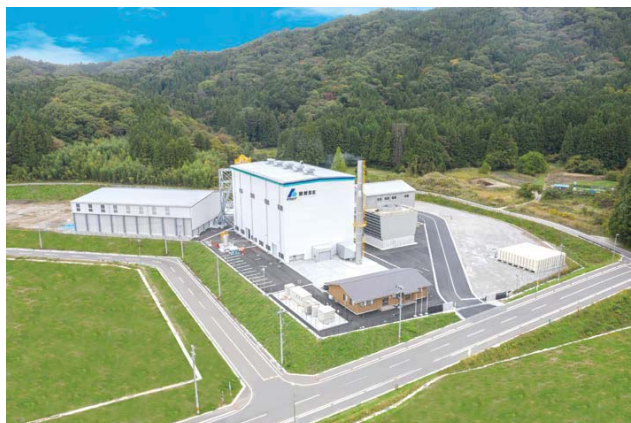
(株)田村バイオマスエナジー「田村バイオマス発電所」外観(今春営業運転開始予定)
