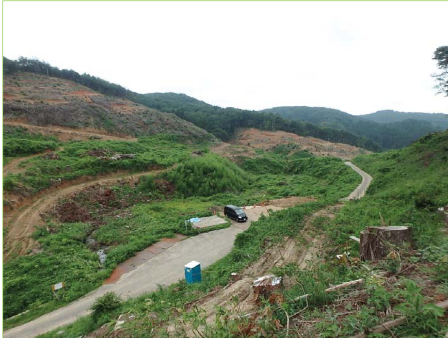
(株)門前クリーンパーク 管理型最終処分場建設予定地にて(2019年7月撮影) 画面後方の山肌や手前の切株などから、処分場造成工事に備えて樹木の伐採が進捗していることが分かる。
