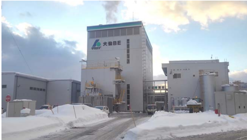
株大仙バイオマスエナジー 協和発電所
