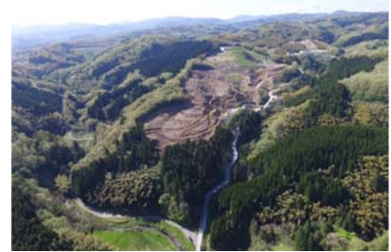
※建設中の北陸環境サービスの管理型処分場
