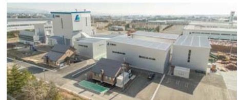
花巻バイオマスエナジー 2017年2月～稼働開始
