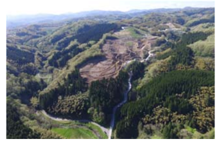
※建設中の北陸環境サービスの管理型処分場
