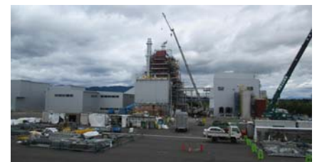
※花巻バイオマスエナジープラント設置工事 (H28/7/19撮影)
