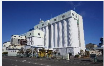
① 静岡工場立体倉庫建て替え
