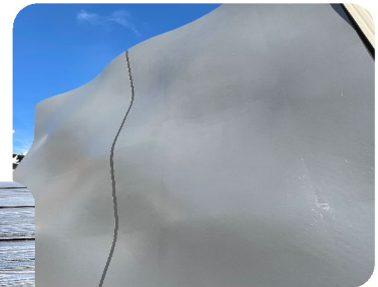
特殊鋼製型枠
