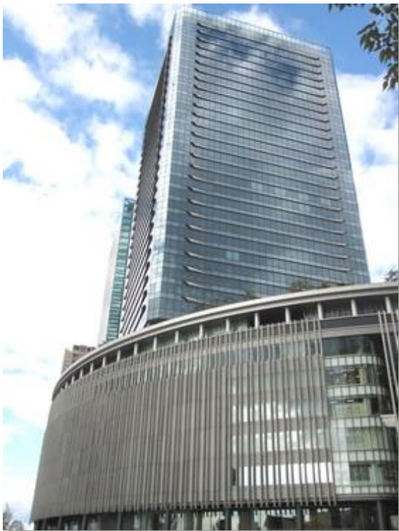
グランフロント大阪 南館・北館 (大阪市北区)
