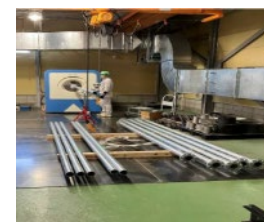
配管フレア加工
