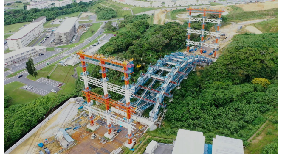
西普天間橋梁(仮称)の施工状況
