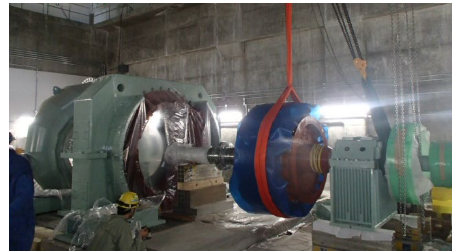
発電機回転子投入
