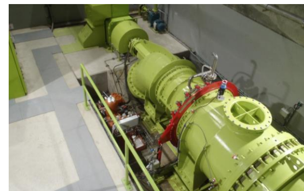
白滝発電所更新
