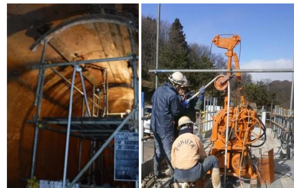
発電所水路上部保全工事(VE提案)
