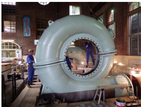
水車組立状況
