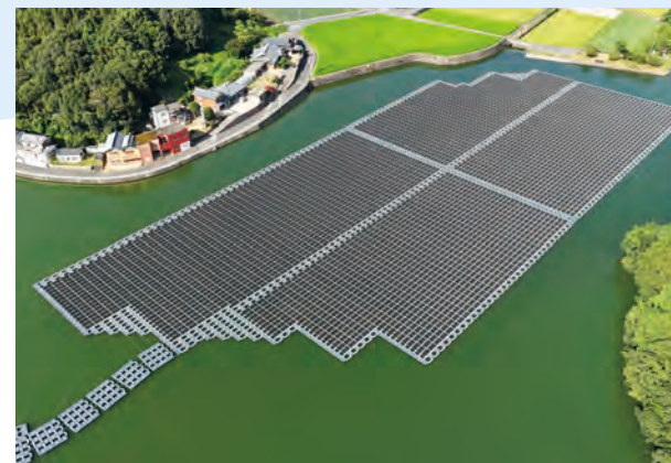
ため池を活用した二ツ池太陽光発電所
