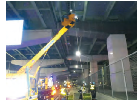
阪神高速道路 通信線路整備その他工事 大阪府 施工：アイ電気通信(株)／当社グループ
