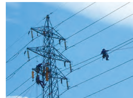
今治線1号他送電線張替 愛媛県
