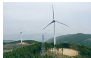
ユース上勝神山ウインドファーム（徳島県） 風力発電所 [送電工事]
