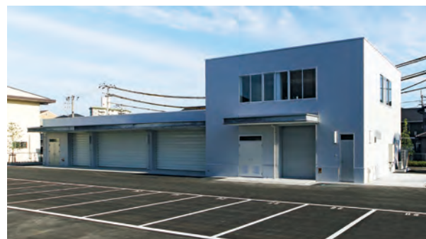
本店社屋 災害対策棟 防災用備品や非常食を常備。大規模災害時には敷地を緊急資材置場、緊急応援車両置場、復旧作業応援部隊のテント設営場所としても利用可能
