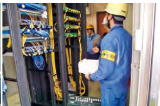
情報通信工事の施工体制整備
