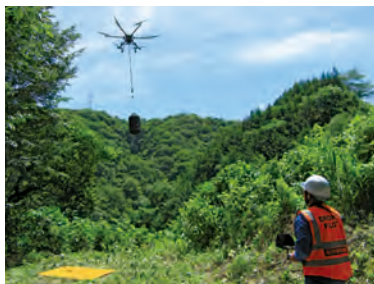
ドローンによる資機材の運搬作業
