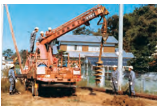
工事現場の機械化
