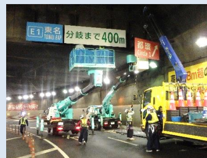
首都高速道路標識補修 (東京都)
