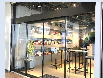
商業施設電気設備修繕 (東京都)
