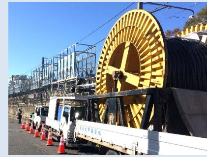
地中送電線新設 (東京都)
