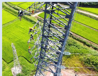
清水南線鉄塔建替 (群馬県)
