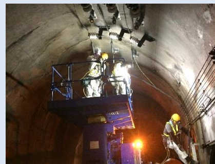
トンネル内配電設備修繕 (福島県/新潟県)
