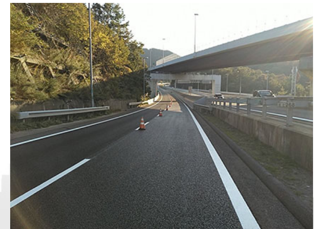
舗装補修大規模修繕工事 (2022-1-北)
