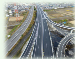
東海環状自動車道 大野・神戸IC~大垣西IC間舗装工事
