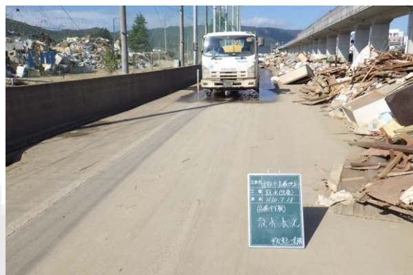
岡山県倉敷市真備町
