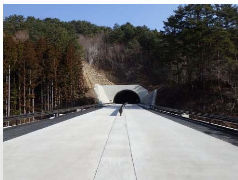
田老地区舗装工事
