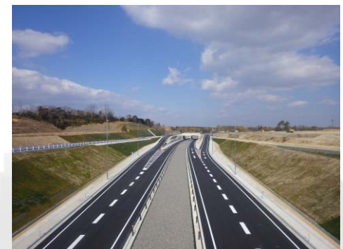
三行北舗装工事
