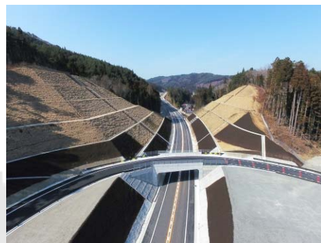
唐桑南地区舗装工事
