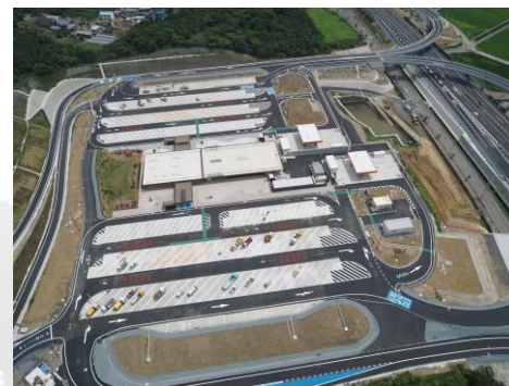
太田パーキングエリア舗装工事
