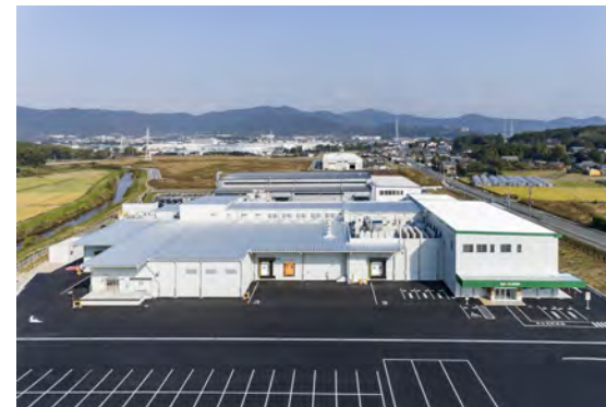
(仮称) 株式会社食研 豊橋工場新築工事(愛知県)
