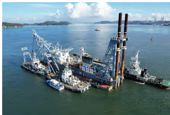
備讃瀬戸北航路(水島航路交差点)浚渫工事(香川県)
