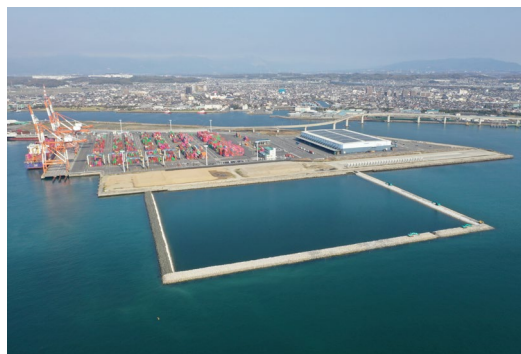
令和4年度 特建港改 第5号 霞ヶ浦地区北ふ頭護岸築造(捨石)工事(その1) (三重県)
