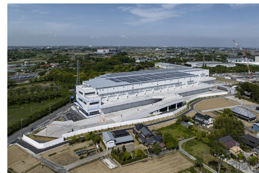
(仮称)加須ロジスティクスセンター新築工事(埼玉県)
