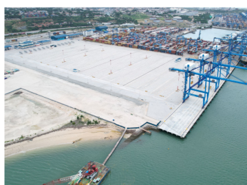
モンバサ港コンテナターミナル開発工事(2期)(ケニア)
