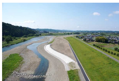
R 1 那珂川右岸小川下流地先低水護岸災害復旧工事(栃木県)
