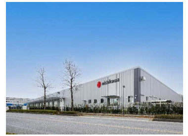
(仮称)西川株式会社埼玉センター新築工事(埼玉県)
