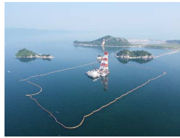
令和2年度八代港大築島土砂処分場地盤改良工事 (熊本県)
