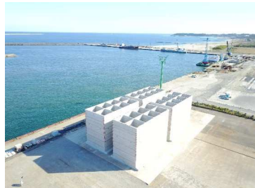
茨城港常陸那珂港区中央ふ頭地区岸壁(-12m)本体工事(茨城県)
