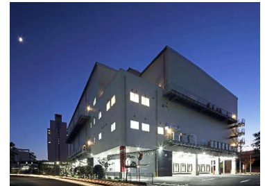
横浜金沢低温DC新築工事(神奈川県)
