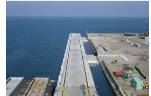
東ひうち棧橋新設工事【L=300m、400tJC搭載】(愛媛県)
