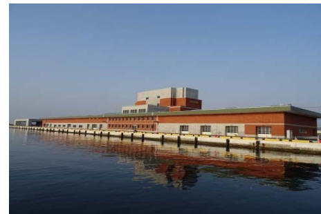
小名浜地域水産業施設復興整備事業(小名浜魚市場凍結品荷捌き施設)(福島県)
