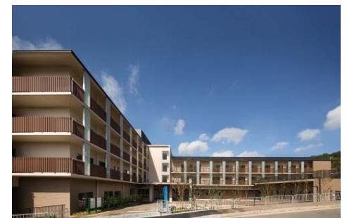
特別養護老人ホーム白島荘建て替え工事(大阪府)
