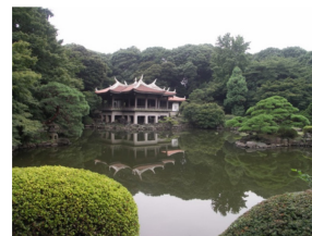
新宿御苑底泥除去工事
