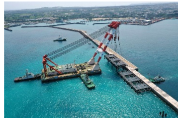
平良港(-10m)岸壁
