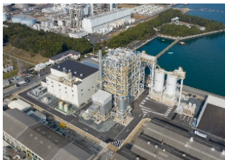
バイオマス発電所
