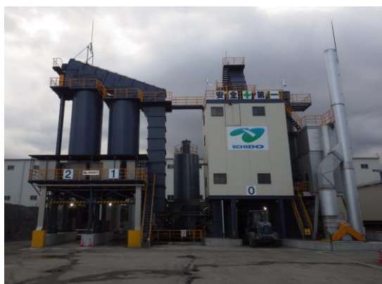
※② 環境対策型アスファルトプラント (埼玉合材センター・埼玉県)
