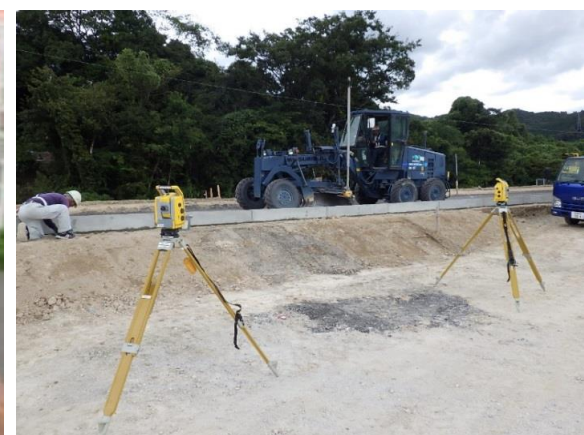
※③ 自動施工（情報化施工）
