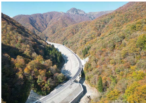
冠山峠道路塚地区改良舗装工事 (国土交通省近畿地方整備局)
