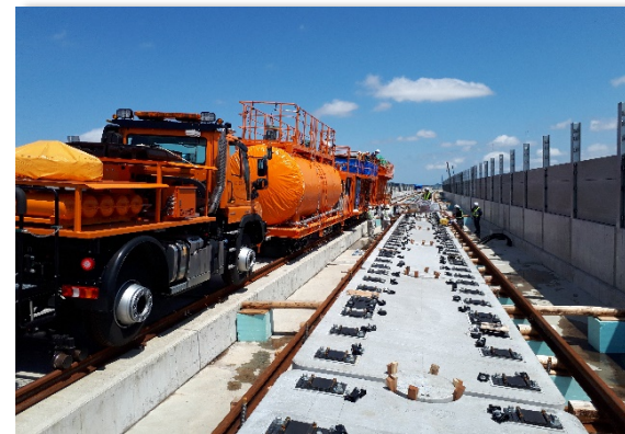
北陸新幹線 福井軌道敷設他工事
