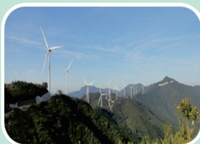
再生可能エネルギー関連工事
